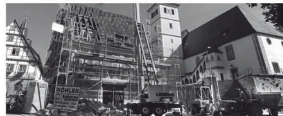
Mit viel Sorgfalt erfolgte der zeitweise Rückbau.
