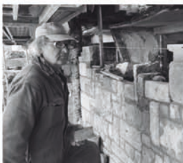
Nur bestehende Steine werden verbaut.
